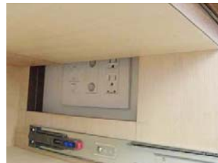
コンセント部 本体加工
