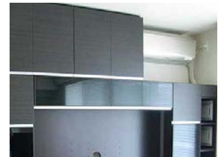
エアコン設置部 本体加工
